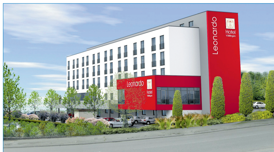
Erfolgreicher Stadtumbau: das derzeit im Bau befindliche City-Hotel
