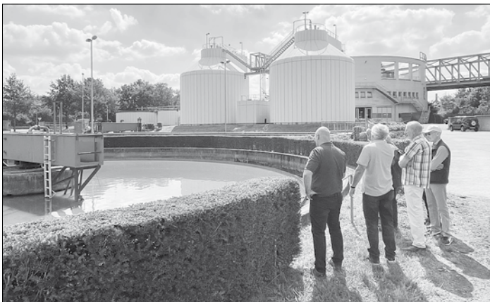
Betriebsingenieur Uwe Woll und EVS-Geschäftsführer Holger Schmitt führen die erste Gruppe mit Bürgermeister Christof Sellen durch die Anlage Fotos: Stadt Völklingen
